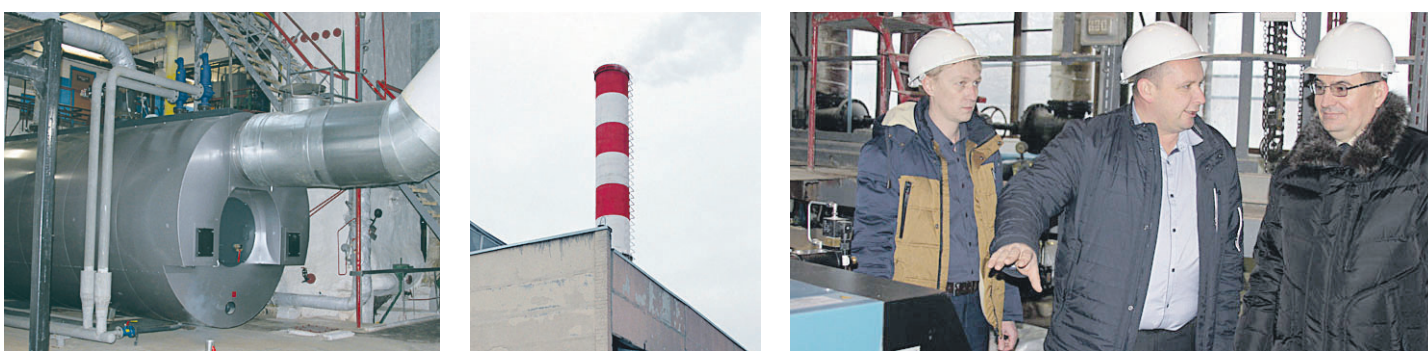
Завершён первый этап модернизации городской котельной
