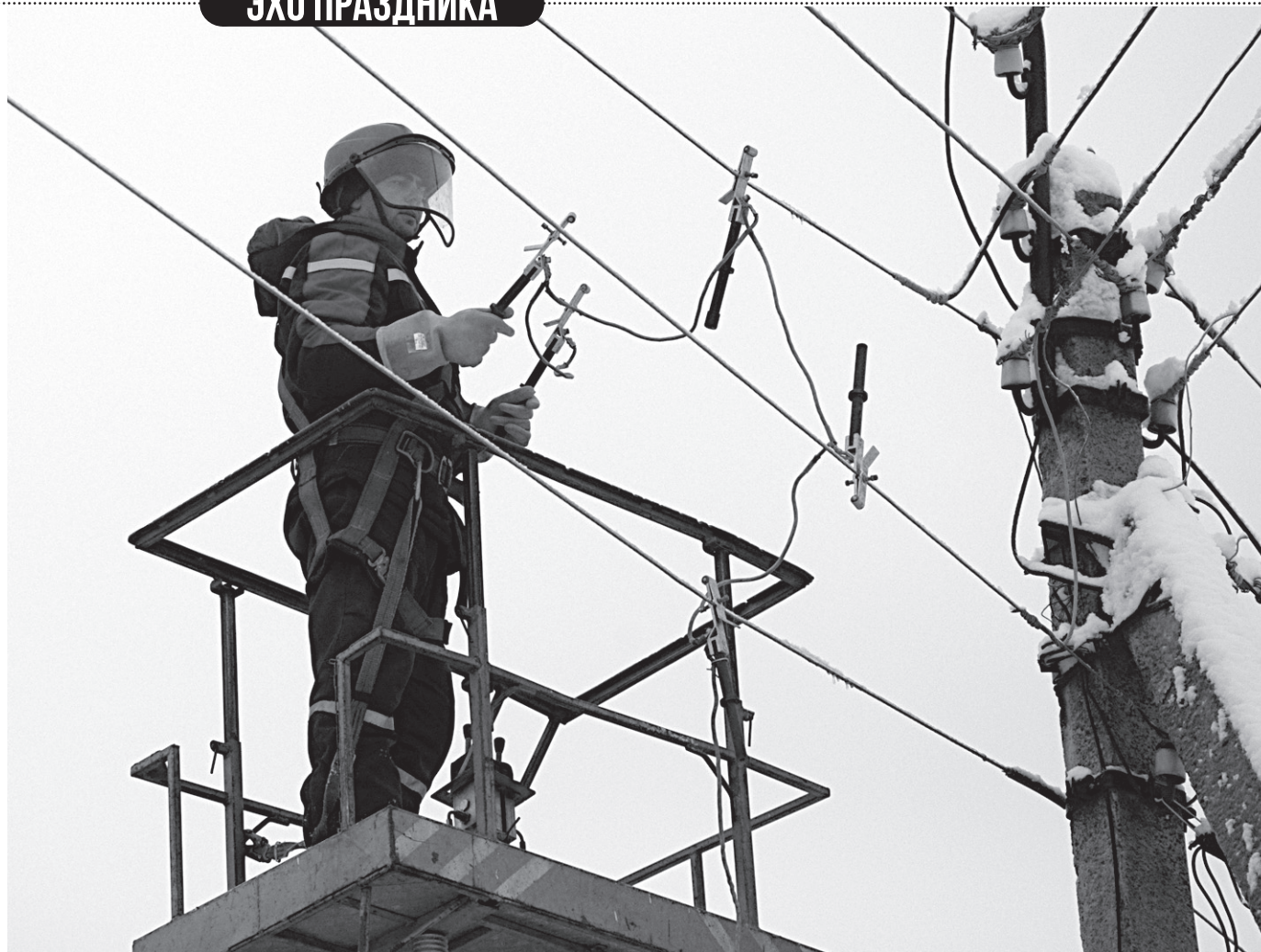
Электромонтер Алексей Руденко производит техобслуживание уличного освещения. Фото Николая Щербинина
